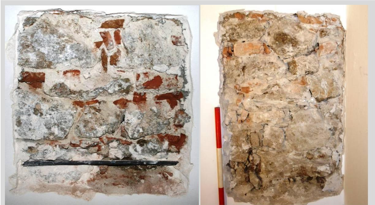
Beispiele für unterschiedliches Netzmauerwerk: Links lagerhaftes, Westmauer von EG9, rechts unstrukturierteres, Südmauer von EG23.
