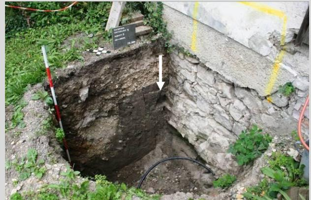
Links Schnitt 1, rechts Schnitt 2. Die Pfeile markieren die Bauhorizonte zwischen den beiden Fundamentteilen links und dem Fundament und aufgehendem Mauerwerk rechts.
