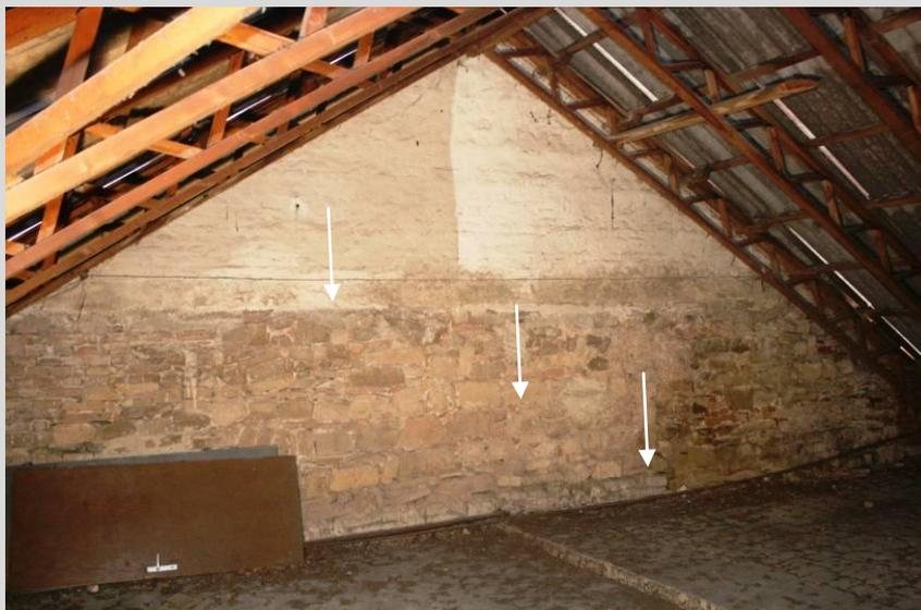
Oben: Stadtmauer, 13. Jahrhundert; rechts schließt die Südfassade der Wasserkaserne an. Unten: Dachboden; die Pfeile markieren die Mauerkrone der Stadtmauer, den vermauerten Wehgang und den rezenten Giebel.
